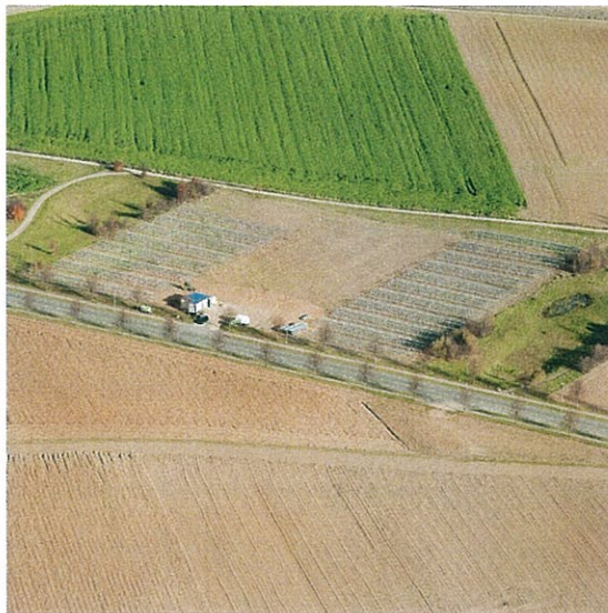
Gewerbegebiet Avantis, Aachen (Luftbild vom 21.11.2011) Freilandanlage Avantis 2: Leistung 1,4 Megawatt Fertigstellung des Solargenerators bis zum 16.12.2011
