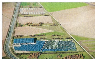
Luftbild auf das Avantis-Gelände. Im Hintergrund sind die Bauarbeiten an der Avantis 2-Solaranlage zu sehen
